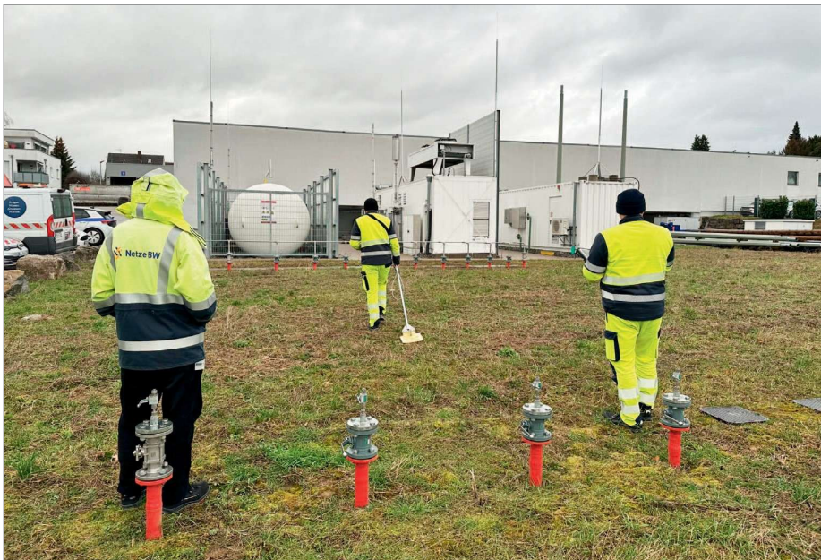
H 2 -Netzbegehung vor der Umstellung auf 100 % Wasserstoff
