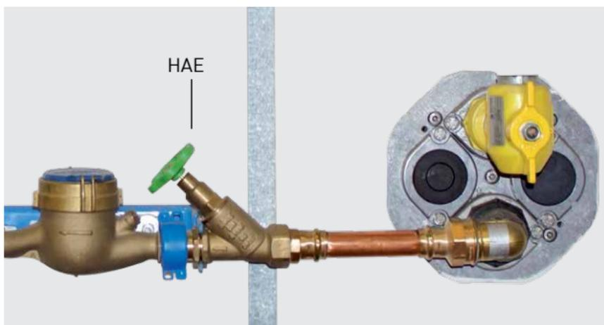
Generell dienen Absperreinrichtungen dazu, die Wasserzufuhr im Falle eines Schadens oder bei kurzfristigen Arbeiten an der Trinkwasser-Installation zu unterbrechen.
