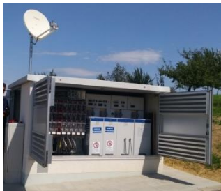
Abbildung 36: Ortsnetzstation mit MS-Messung
