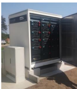
Abbildung 37: Batteriespeicher 120kWh/ 120 kW
