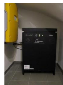
Abbildung 39: Batteriespeicher 9 kWh / 4,6 kW
