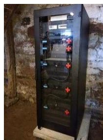
Abbildung 38: Batteriespeicher 19 kWh / 19 kW
